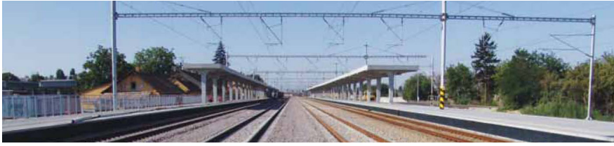
Figure 4: Modernised ŽST Nové Mesto nad Váhom [5].
