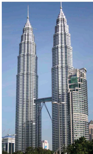
a) Petronas Towers (410 m), 1998
